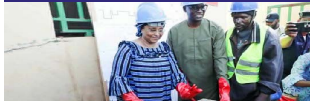
La ministre de la Santé et du Développement social, Assa Badiallo Touré , pose la première pierre pour la construction de deux entrepôts modernes de stockage de médicaments en Commune IV du district de Bamako, le 22 juin 2026.
