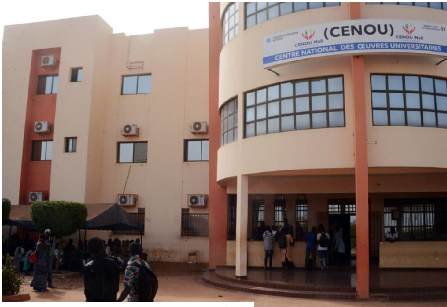
Les infrastructures restent largement insuffisantes pour accueillir tous les étudiants.
