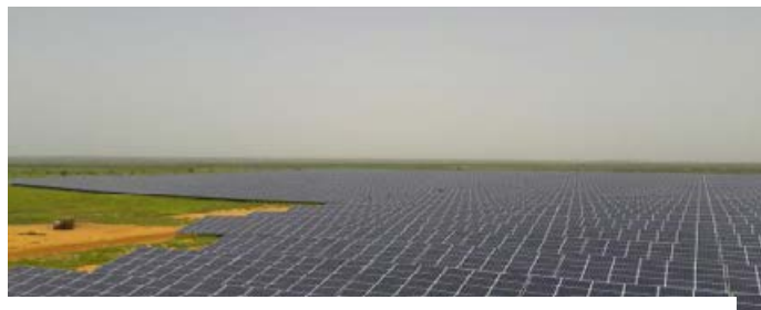
Le parc de Bokhol au Sénégal doté de 75 000 panneaux solaires.
